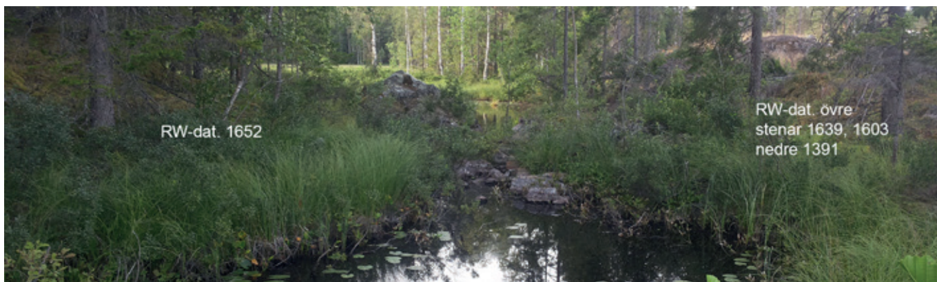
Dammvall 12 med datering
