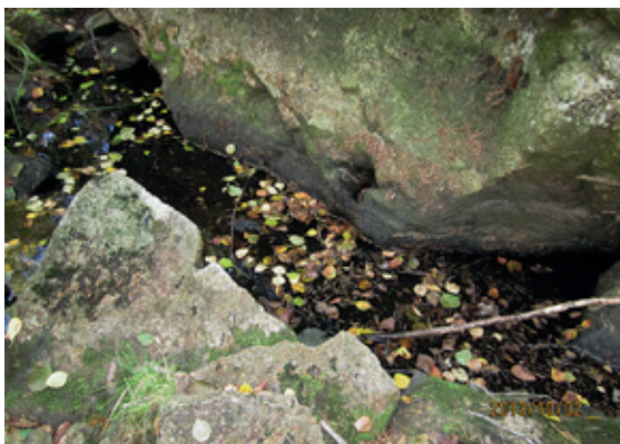
Infästningar, grävd kanal Foto: Rolf Eriksson
