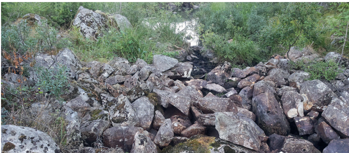
Dammvall 12 sedd från L. Bjurdammen, skrotsten.
