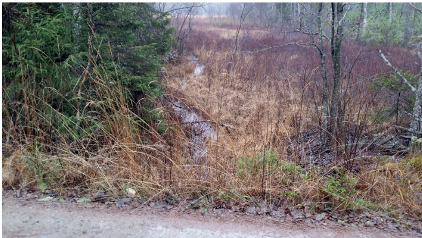
Dämning 11 där "Olsbovägen" går över på gamla dammvallen
