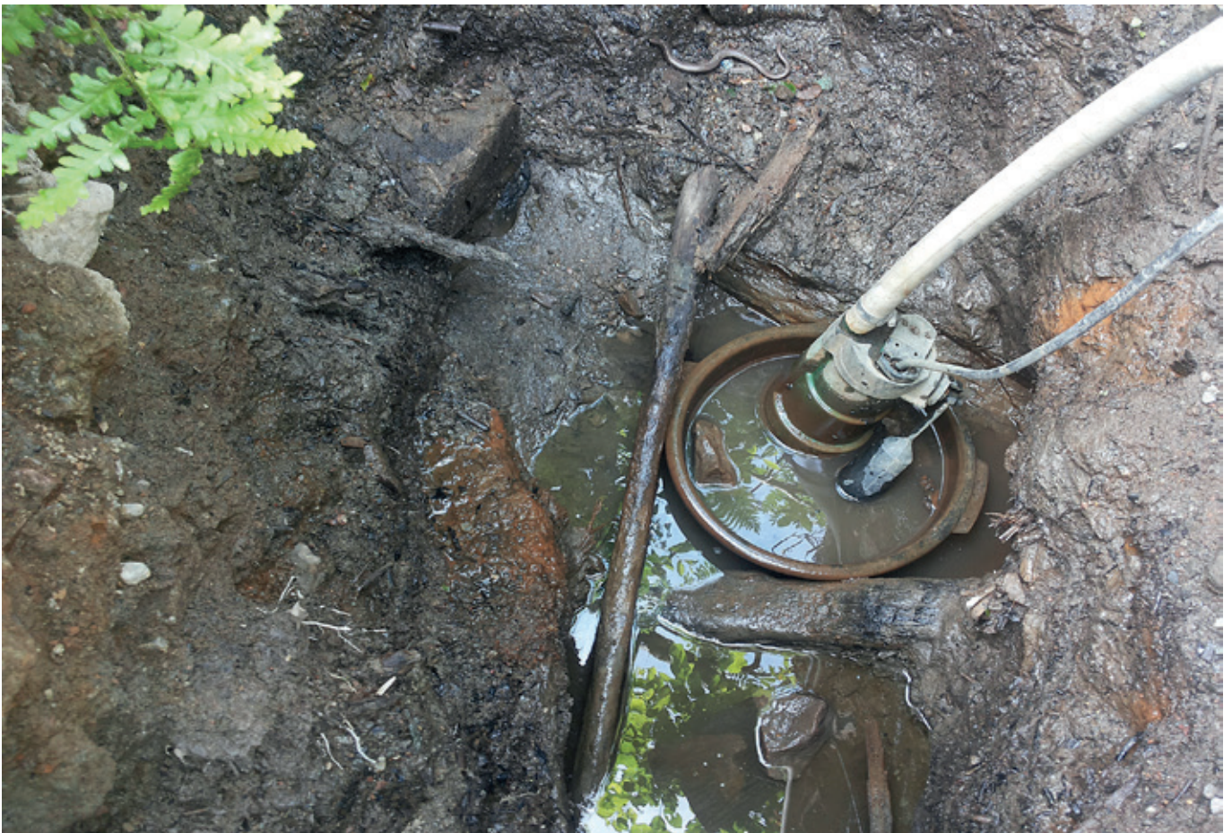
Bränd träkonstruktion under slagghvarp.
