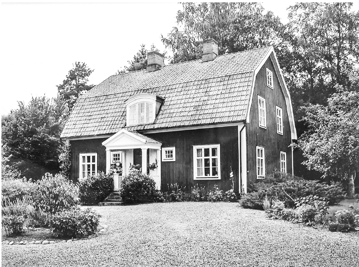
Kvarngården efter renoveringen 1925.
