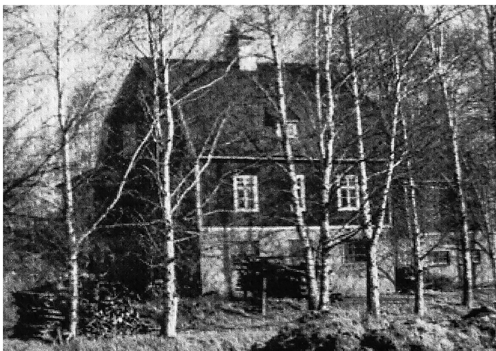
Vinkelbyggnaden sedd från väster, baksidan. Kvarngården t.v. utanför bild. Foto: Privat
